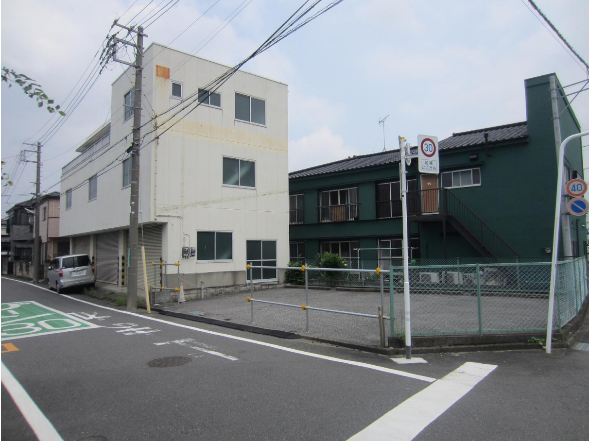
現地写真 倉庫
