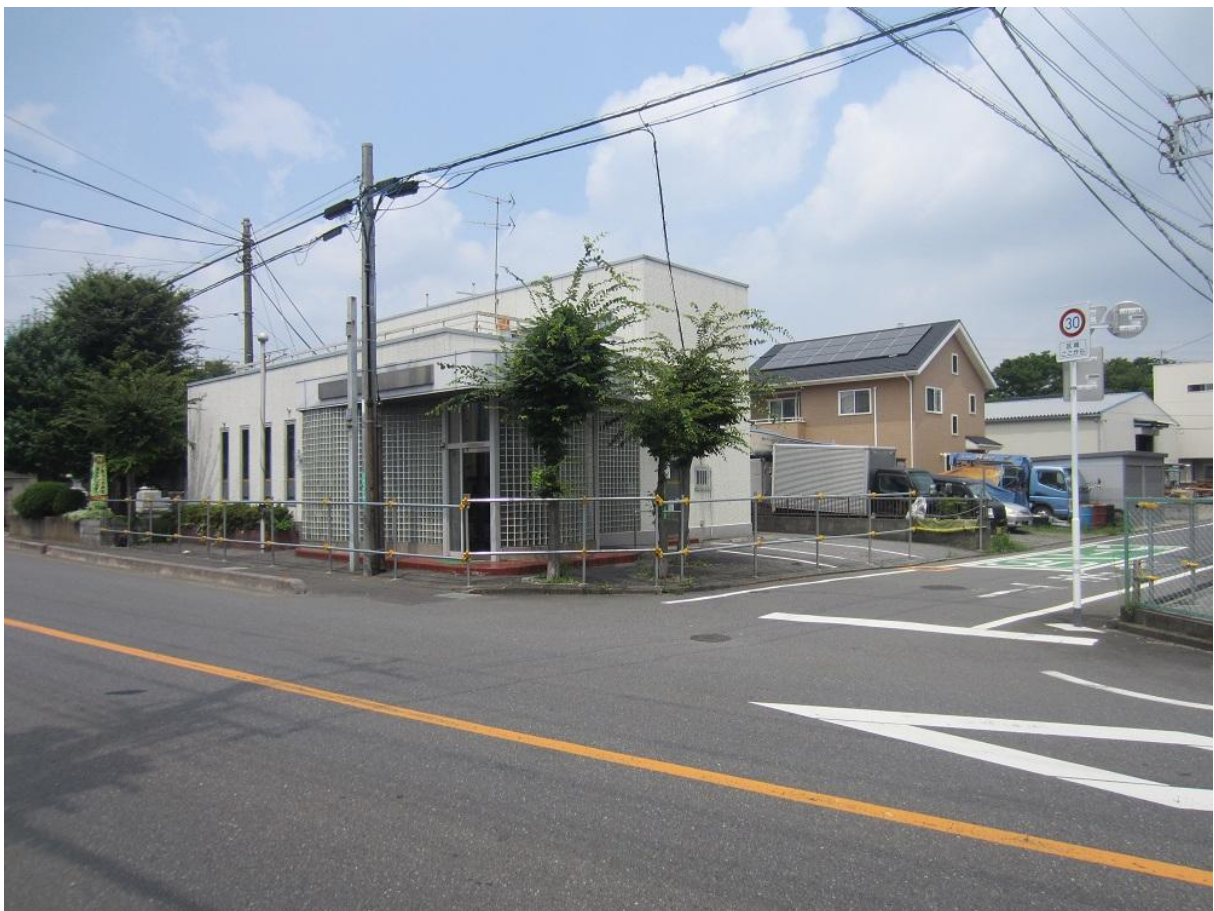
現況写真 (解体整地売却)
